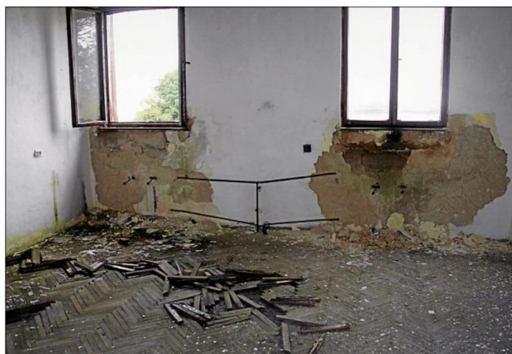
Die Heizkörper wurden aus den meisten Gebäuden gestohlen, das Mauerwerk bröckelt und die Fußböden brechen auf.
